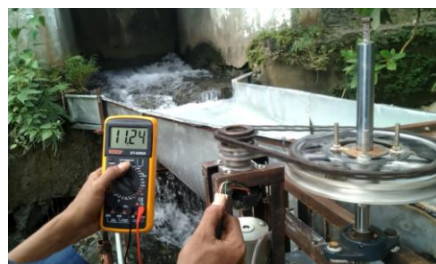
Gambar 3 Pengujian Generator AC
